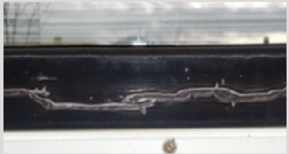
Ursache: Chemikalienangriff; Folge: Anlösen der Oberfläche © GEALAN Fenster-Systeme GmbH
