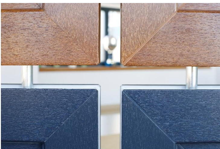
Abbildung 20: „wulstlos“ geschweißte Ecken (links), genutete Ecken (rechts)
