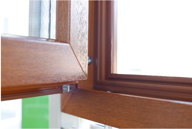
Abbildung 19: genutete und farblich angepasste Ecke
