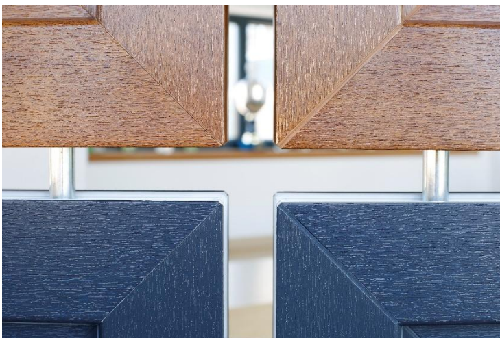
Abbildung 20: „wulstlos“ geschweißte Ecken (links), genutete Ecken (rechts)
