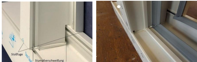
Abbildung 25: stumpf geschweißter Pfosten (AD), Abb. 20b stumpf geschweißter Pfosten (MD)
