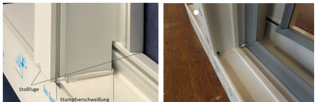
Abb. 20a stumpf geschweißter Pfosten (AD), Abb. 20b stumpf geschweißter Pfosten (MD)
